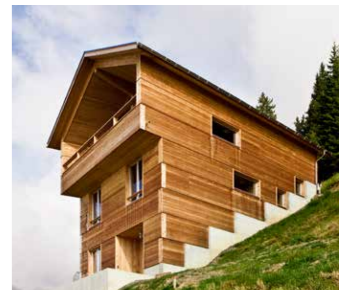
Ferienhaus Biel Kinzig, 2006 Das Erstlingswerk: ein Ferienhaus in den Urner Alpen. Das steile Gelände, die Notwendigkeit des Bauens mit dem Helikopter sowie die Tradition der Strickbauweise prägten den Entwurf. Fotograf: Basil Stücheli, Zürich
