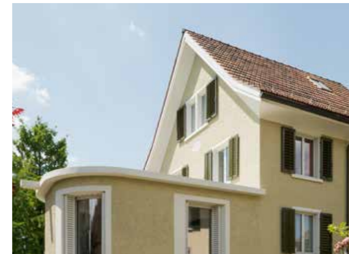
Anbau Wohnhaus Hombrechtikon, 2011 Sanierung, Dachausbau und Anbau. Mit dem kleinen Anbau gewinnt das Haus einen zusätzlichen Wohnraum und über die kleine Terrasse einen direkten Gartenbezug. Der Anbau ist als vorgelagerter Erker konzipiert. Neu und Alt verschmelzen zur neuen Einheit. Fotograf: Beat Bühler, Zürich
