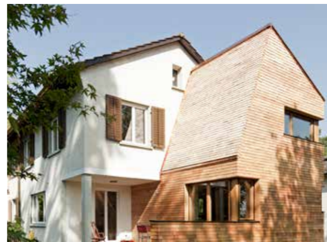
Anbau Wohnhaus im Zürcher Friesenbergquartier, 2011 Sanierung und Ergänzung eines kleinen Wohnhauses um eine Wohnküche, ein Zimmer und eine Terrasse. Der Anbau - ein mit Schindeln verkleideter Schopf - wird zur neuen Adresse des Wohnhauses im durchgrünerten Gartenstadt-Quartier. Fotograf: Beat Bühler, Zürich
