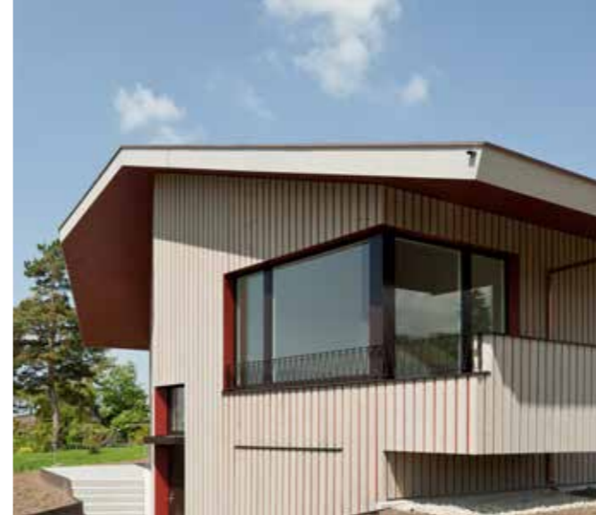
Einfamilienhaus in Wetzikon, 2010 Das kleine Haus gewinnt über einen Splitlevel-Schnitt und innere Durchsichten räumliche Grosszügigkeit. Das markante Dach und die zweilagige Vertikalschalung der Fassade verorten das Gebäude am Übergang zur Landwirtschaftszone. Fotograf: Beat Bühler, Zürich
